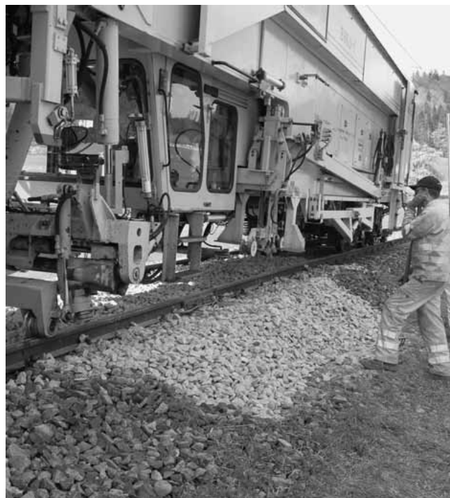
Einsatz einer Sersa-Grampmaschine auf der DVZO Strecke
