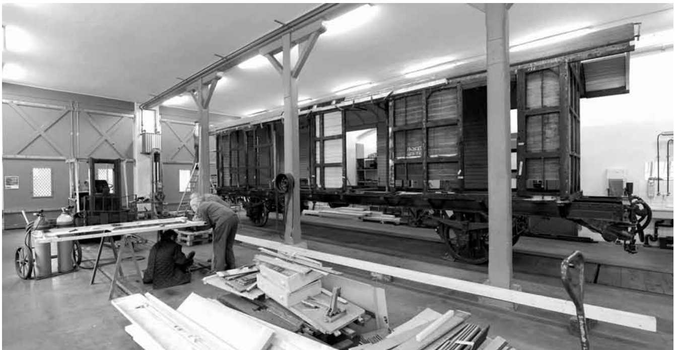
Revisionsarbeiten am FZ 203 in der Remise I in Uster
