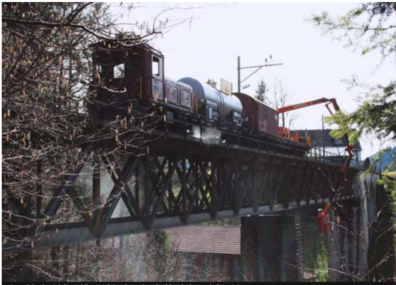
Mit Hochdruck wird die Stahlkonstruktion der Weissenbachbrücke in Neuthal gereinigt.
