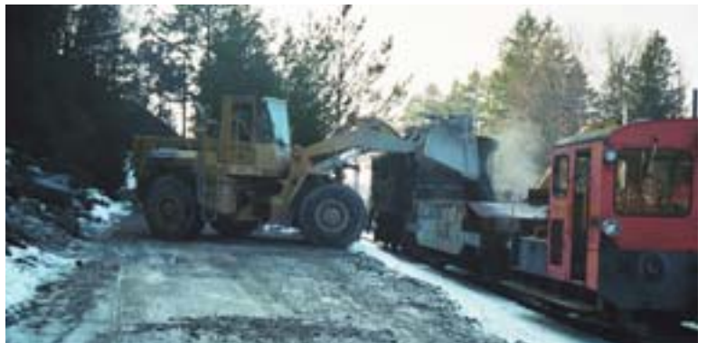
Im FBB-Werk Bäretswil Tobel holt der DVZO-Bauzug die nötige Menge Schotter.
