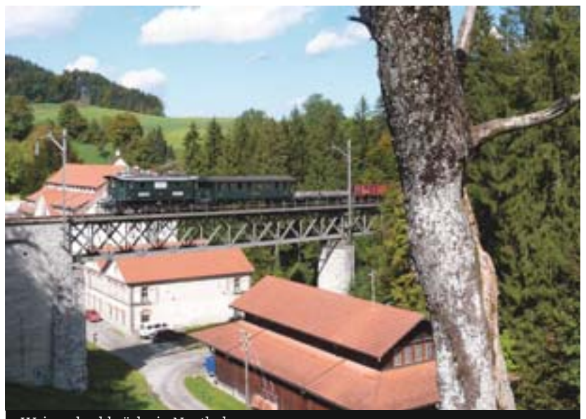
Weissenbachbrücke in Neuthal.
