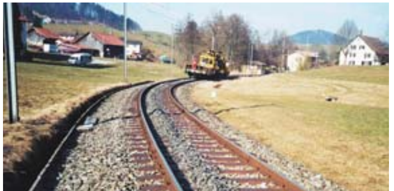
Im DVZO-Gleis verteilter Schotter.
