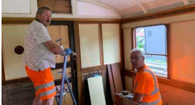
Arbeiten am Innenausbau des C2 422
