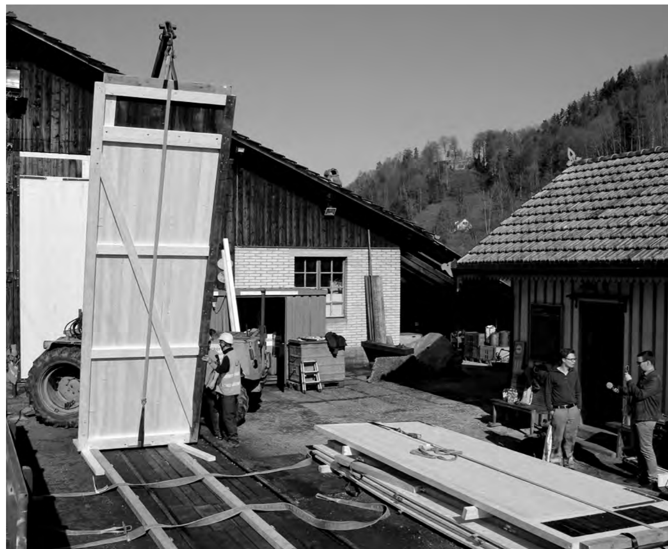
Im April 2018 werden die neuen Depottore in Bauma montiert
