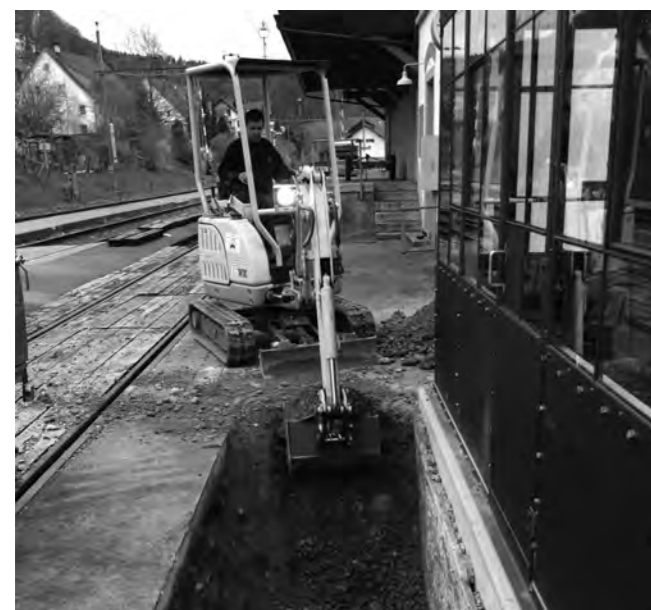
Vorbereitungsarbeiten für die Seilzüge des Stellwerks Bäretswil und der mobile Zuganzeiger für die Kundeninformation in der historischen Bahnhofshalle in Bauma
