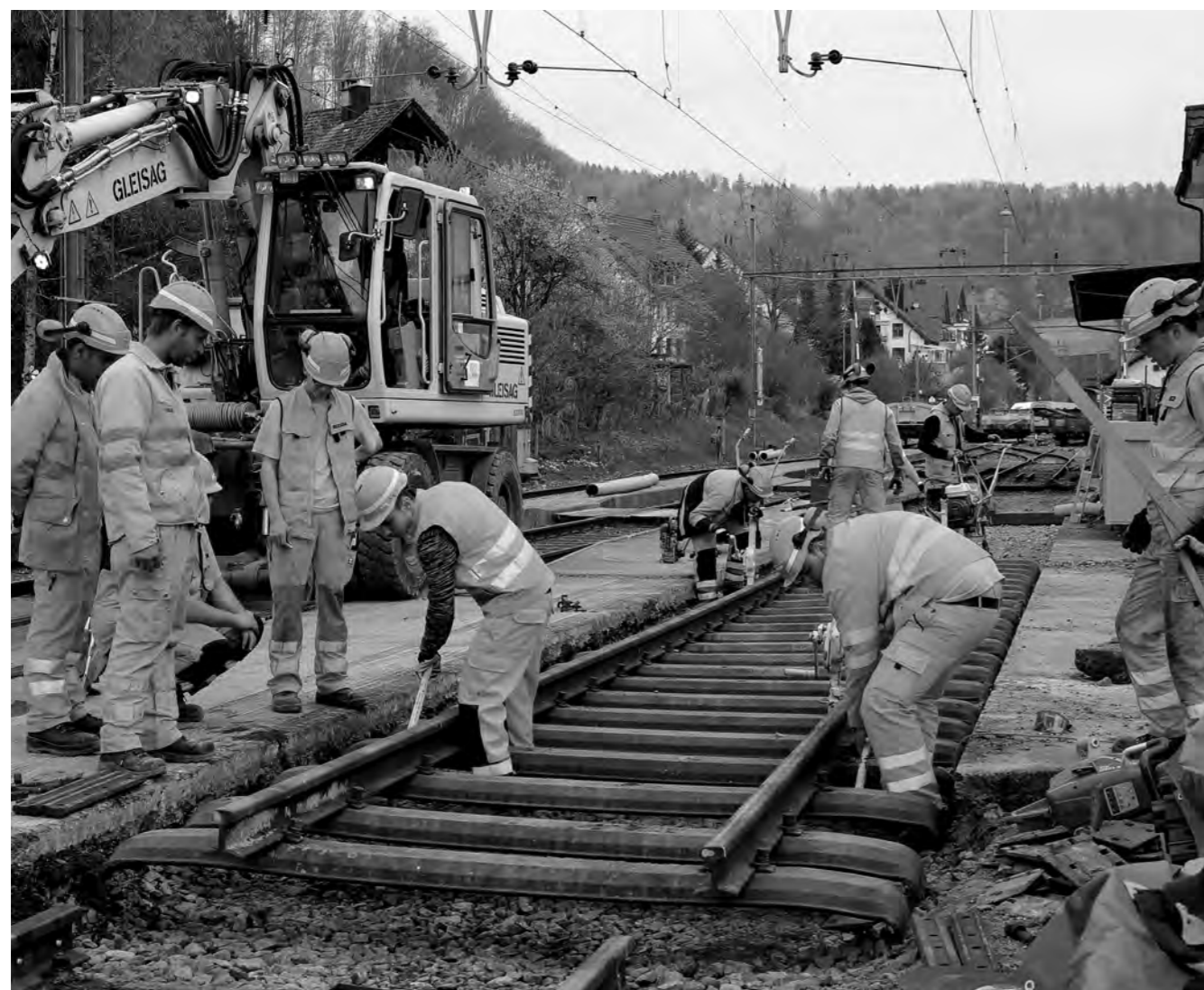
Erneuerung des Gleis 1 im Bahnhof Bäretswil im April 2017.
