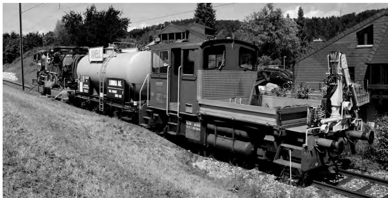
Arbeiten, die keine sichtbaren, dafür spürbare Spuren hinterlassen: Spülung der Entwässerungsleitungen sind wichtig im Fahrbahnunterhalt
