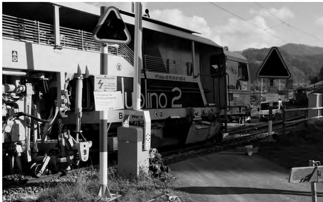
Ungewohnter Gast auf unseren Gleisen – Stopfmaschine Duolino 2 der Gleisbaufirma Sersa AG im Einsatz an der Sanierung des Bahnübergangs Hinterwies in Bauma.
