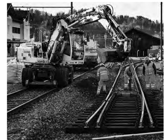
Der Einbau der Doppelkreuzungsweiche wird vorbereitet
