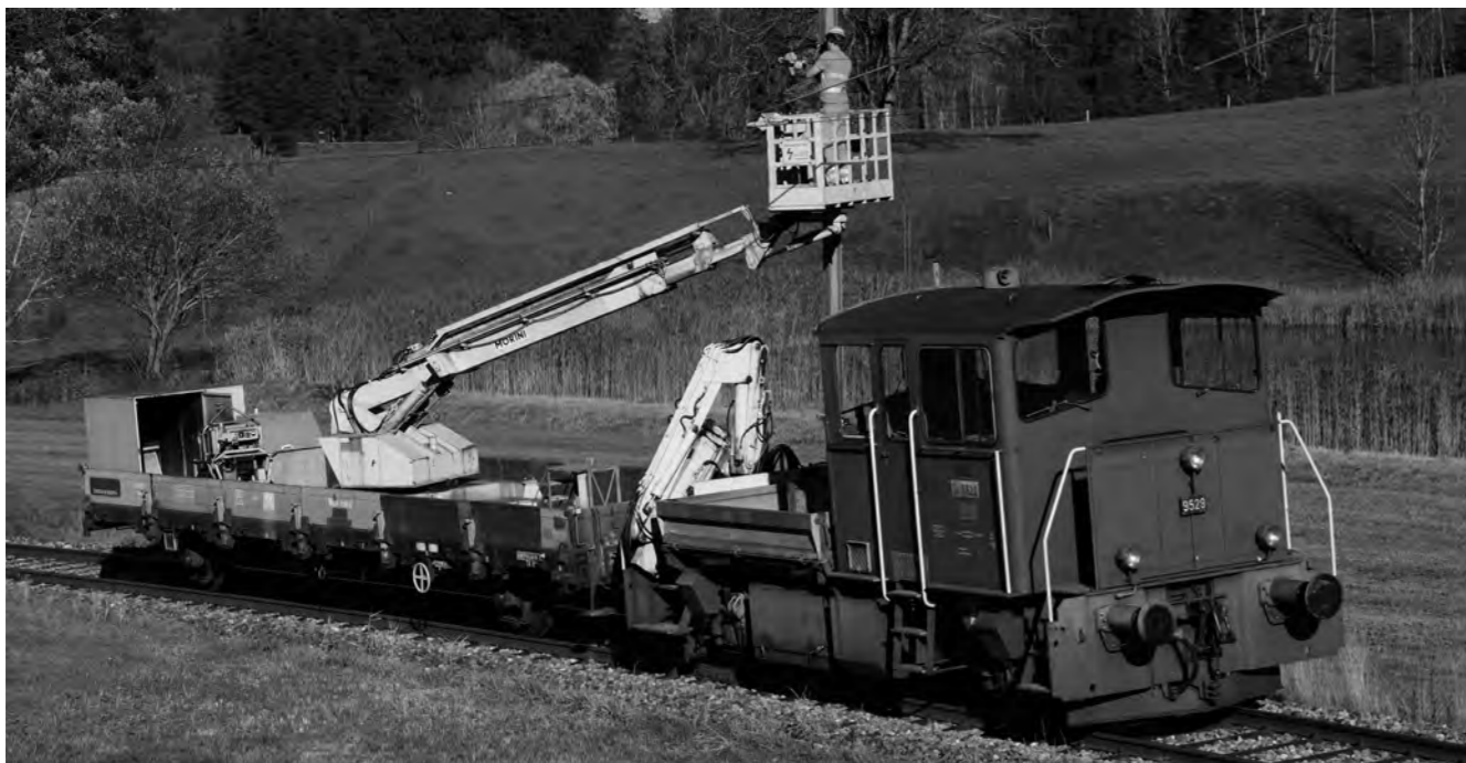
Das Ausbessern der windschiefen Fahrleitung besorgen unsere Spezialisten weitgehend mit eigenen Mitteln
