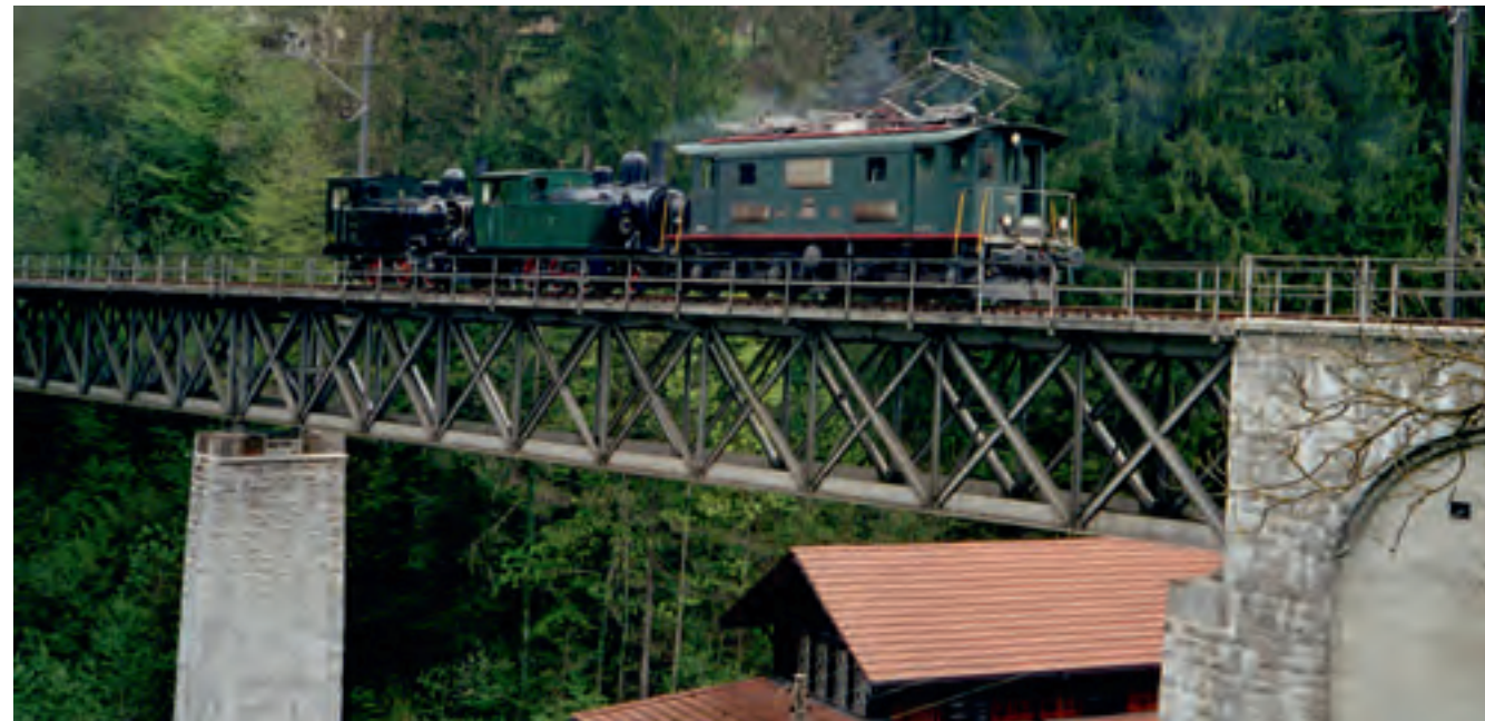
Belastungsprobe der sanierten Weissenbach-Brücke im Neuthal mit 164t
