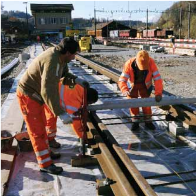
Nivellieren der neuen Gleise am 4. November 2009
