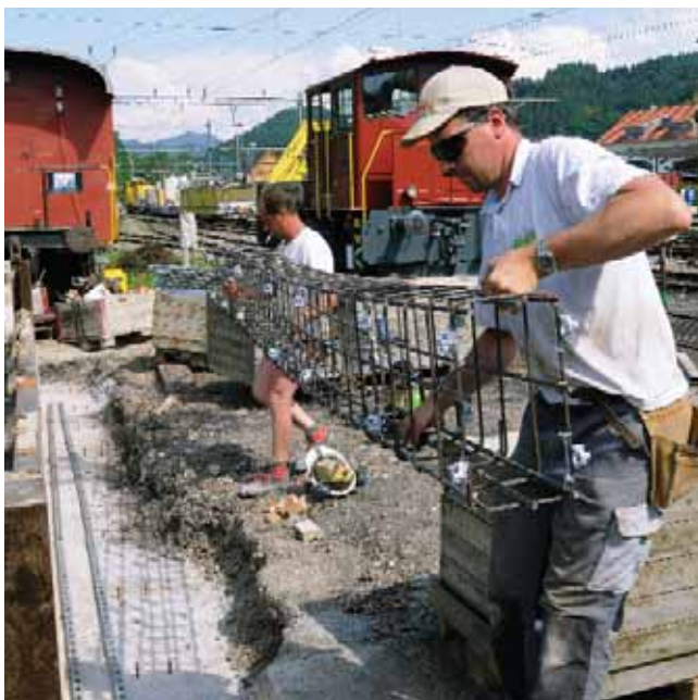
30. Juni 2009: Arbeiten am Fundament
