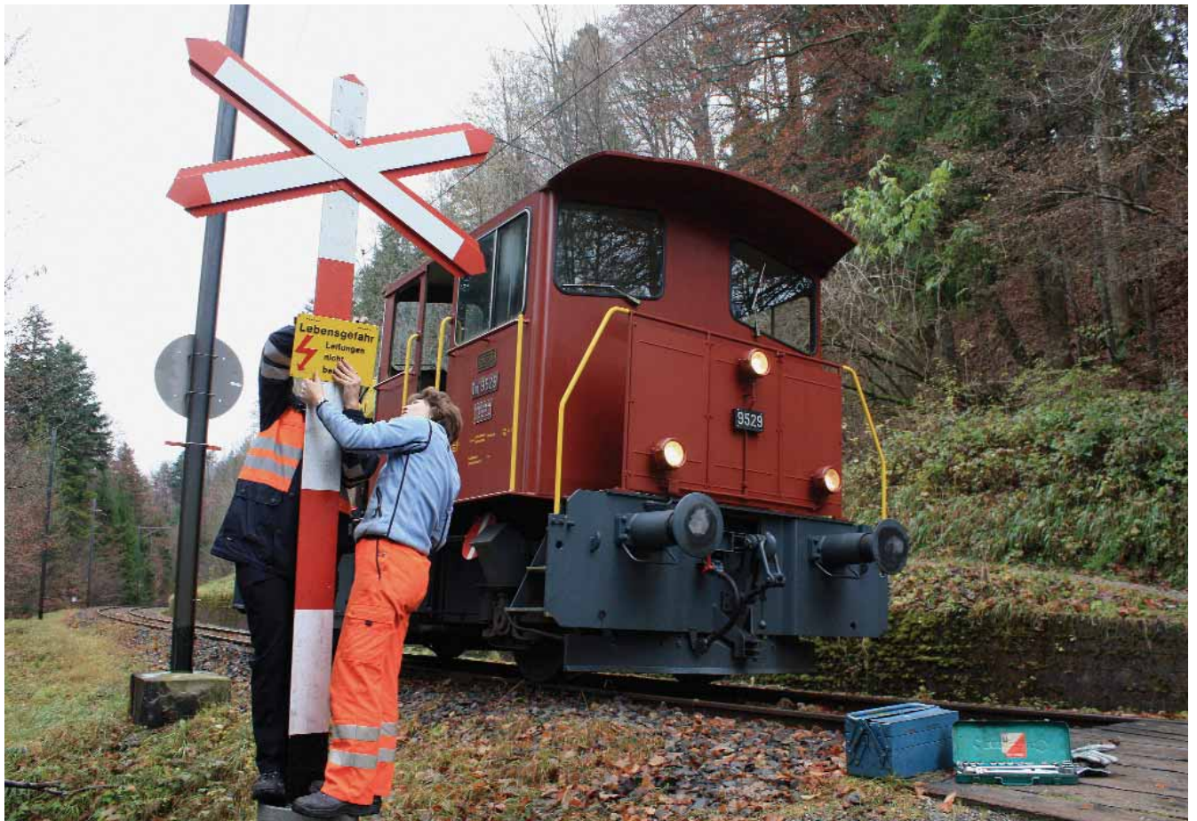
Ein nigelnagelneues Andreaskreuz wird aufgestellt
