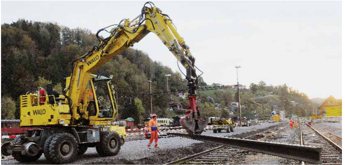
Vorarbeiten Bahnhofhalle – 21. Oktober 2009: Die Gleise der Berta-Gruppe in Bauma werden rückgebaut
