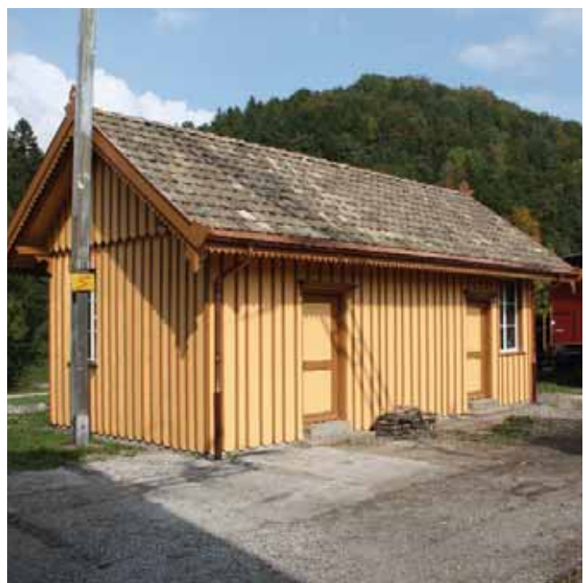
In Bauma zu neuem Leben erweckt: Bahndienstgebäude Wollhusen
