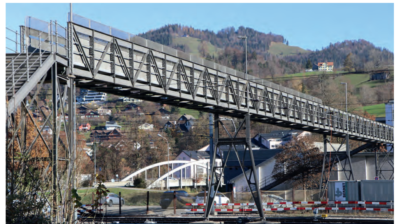
Die Passerelle vor dem Rückbau in Wattwil
