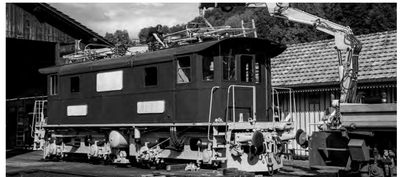
«Endspurt» – Montage des neu zusammengesetzten Pantographen vor dem Depot in Bauma
