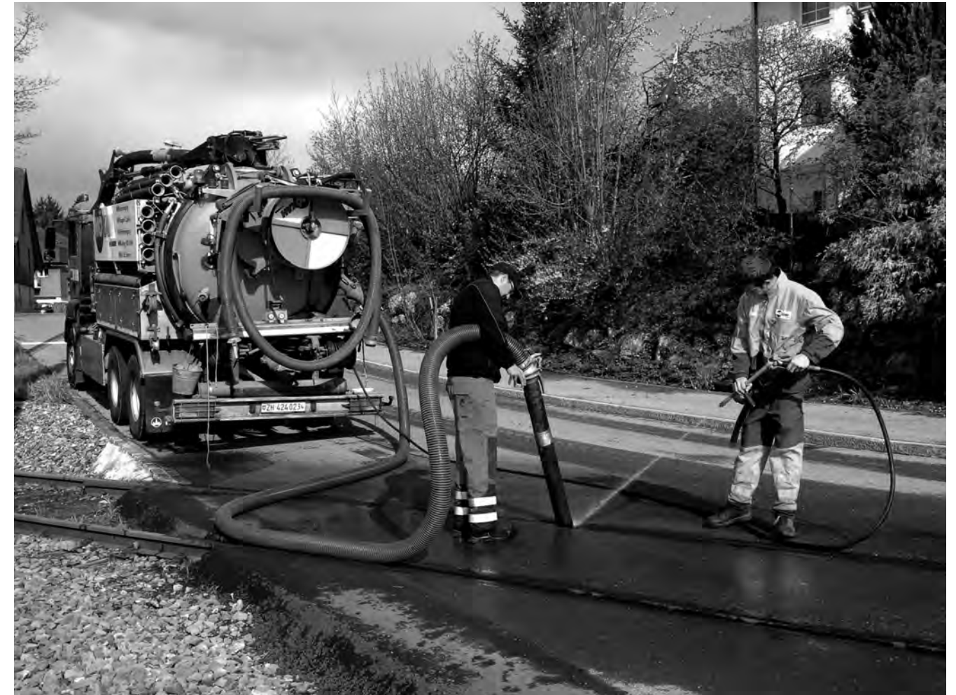
Rilleinreinigung am Bahnübergang Bäretswil: Der Schlamm wird direkt abgesaugt und entsorgt.
