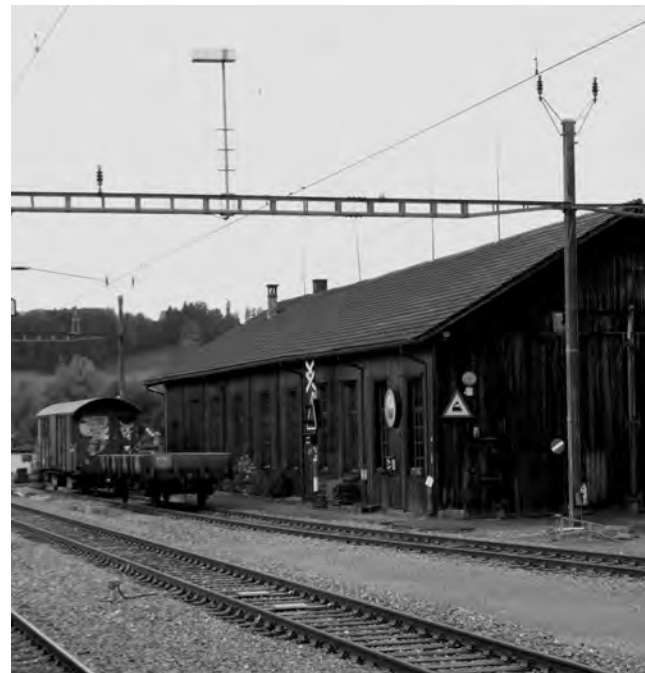
Neue Gleisanlage vor dem Depot Bauma. Der Bahnübergang ist aufgehoben, Zugang zum Depot über Fussweg via Sennhüttenstrasse.
