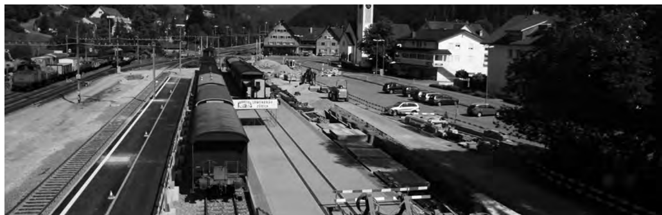
Der Bahnhof Bauma verändert sich: Auf der einen Seite baut die SBB die neuen Gleis- und Perronanlagen, auf der anderen Seite erstellt der DVZO das Fundament für die historische Bahnhofshalle.
