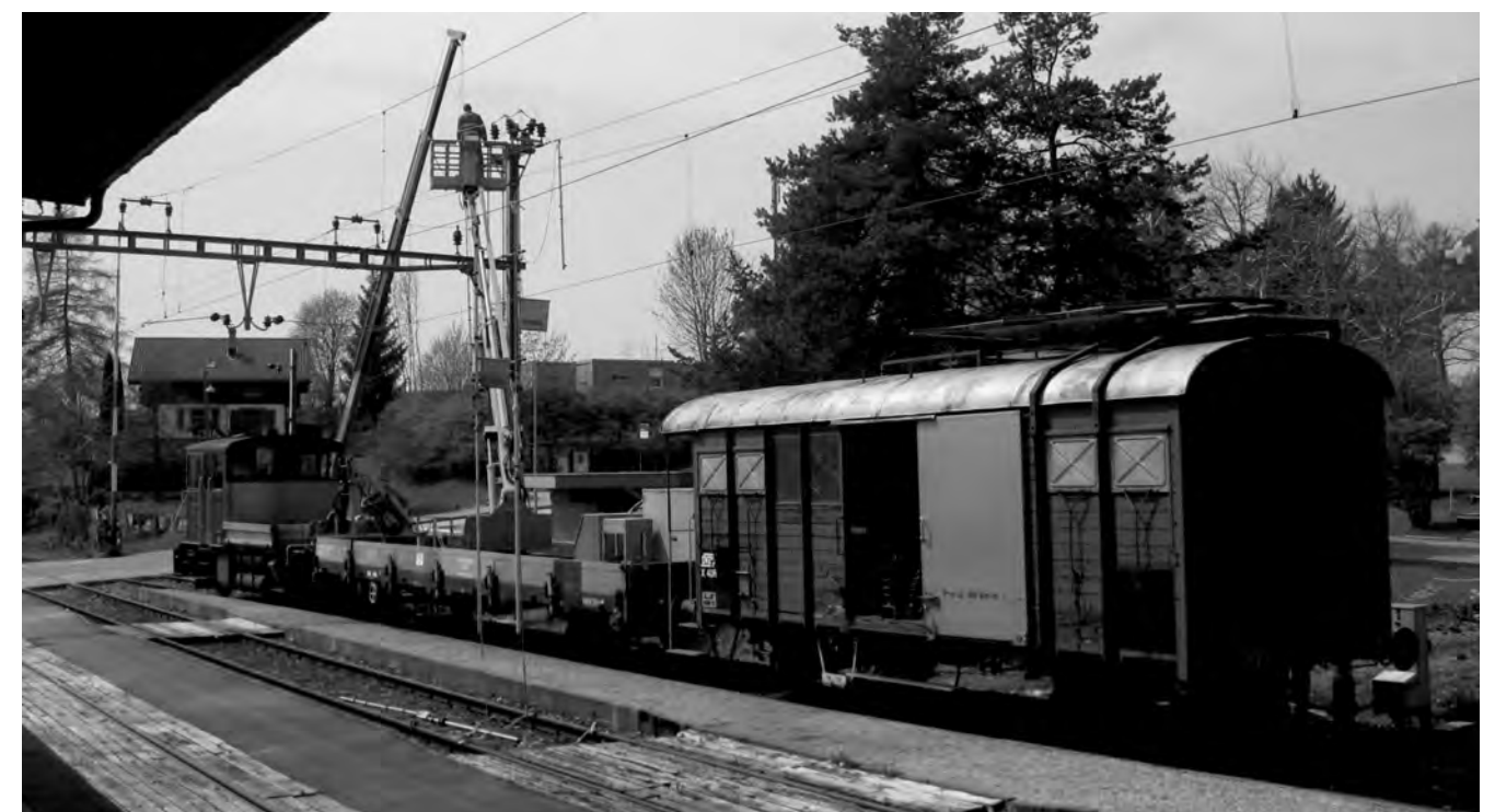
Bauzug in Bäretswil: Lukas Trüb wechselt mit Hilfe des Fahrleitungsmontage-Wagens die Hörnerschalter in Bäretswil aus.
