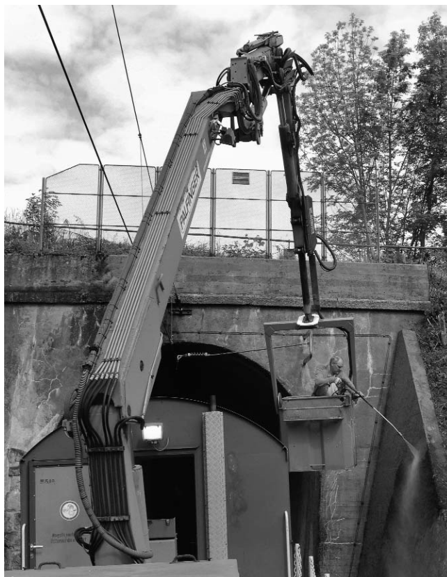
Stützmauern und Tunnelportale werden gereinigt
