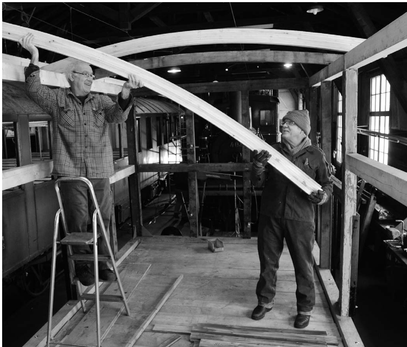
Wiederaufbau des Bierwagens der Felsenbrauerei Wald
