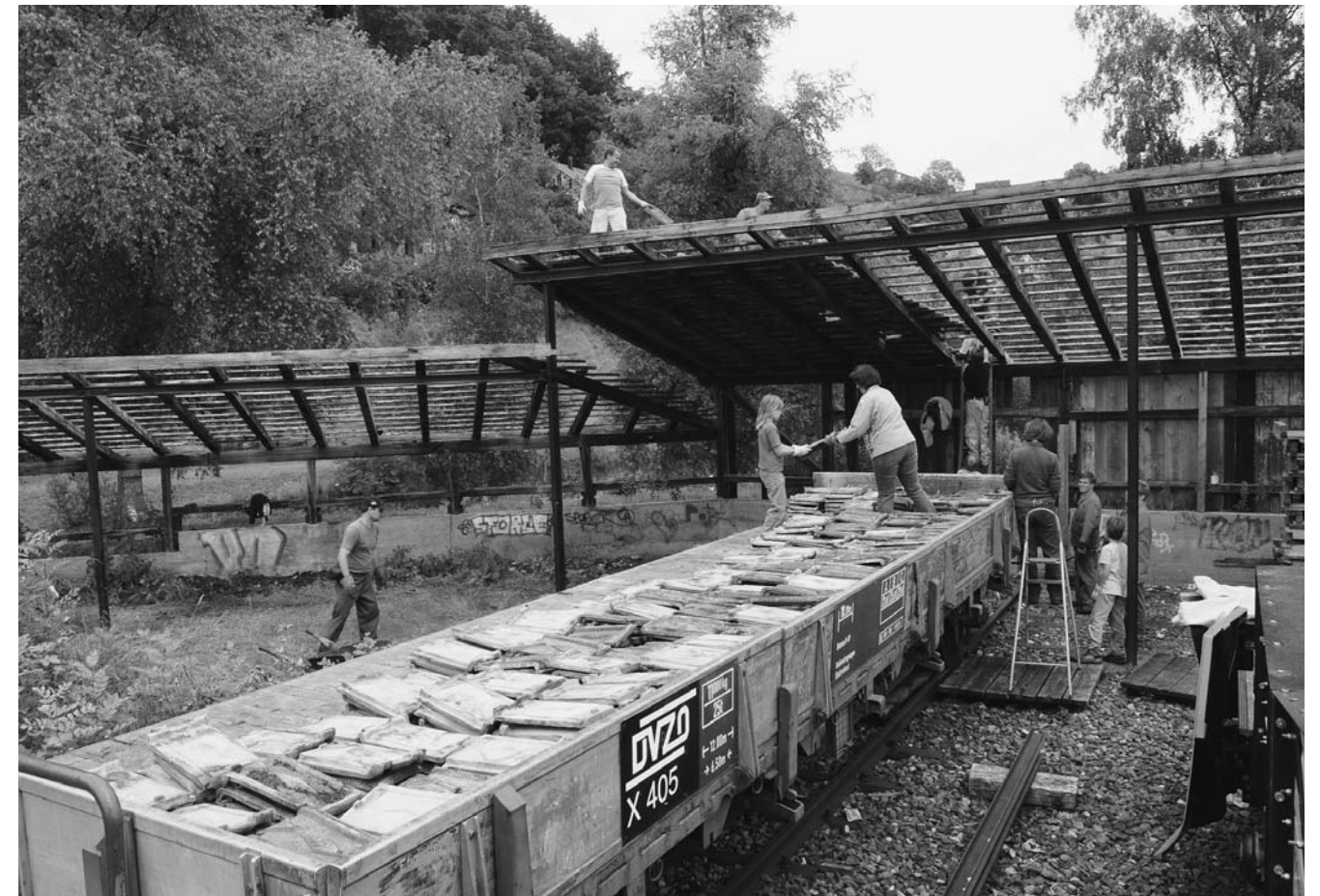
Abbruch des alten Bahnmeisterschopfs in Bauma
