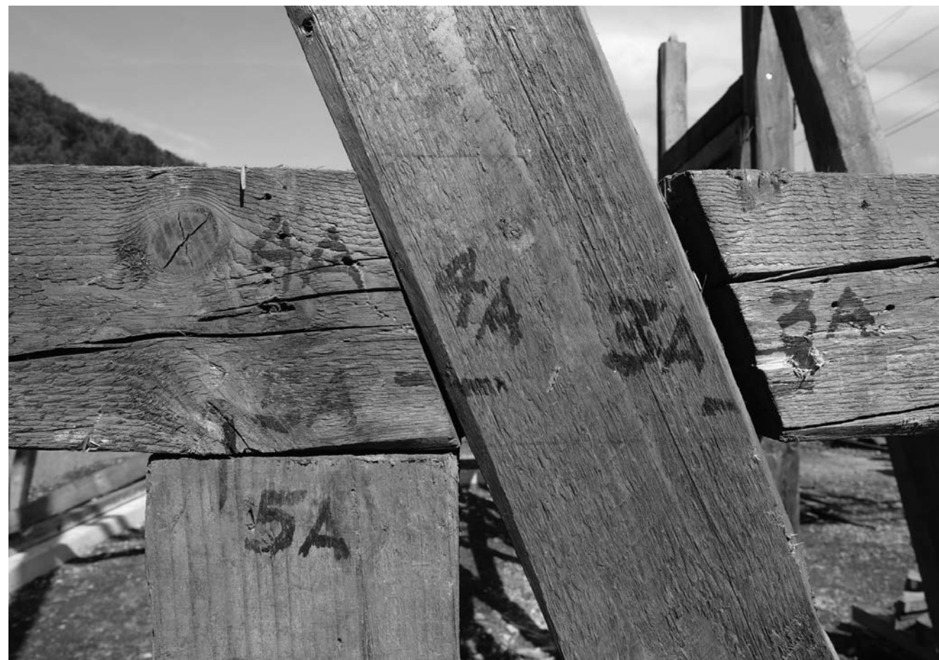
Holzfachwerk des Bahndienstmagazins im Wiederaufbau
