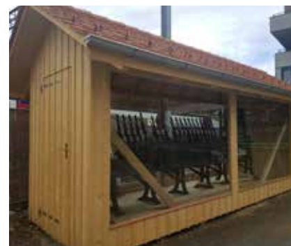
Das Häuschen im Kontext der Lokremise
