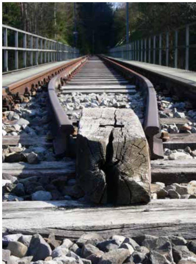
Fangschienenabschluss am Viadukt Neuthal
